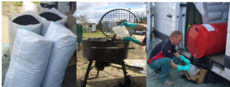
Phase 2: mise en œuvre de la sous-couche amortissante composé d'un mélange de granulés de SBR en caoutchouc noir et d'une résine polyuréthane sans solvant. Mise en œuvre à la taloche et à l'eau savonneuse (donc sans produit néfaste pour l'environnement).
